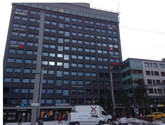
Fastigheten Färöarna 3 (Kista One) som förvärvades av Kungsleden från Areim.
